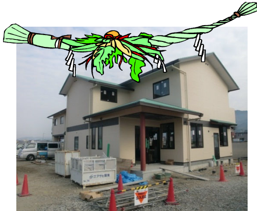
建設中の スパークル
